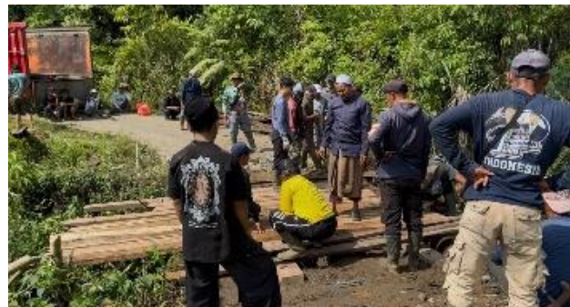
Gambar 11. Perbaikan jalan menuju Citalahab Sumber: Dokumentasi Penulis, 2026
